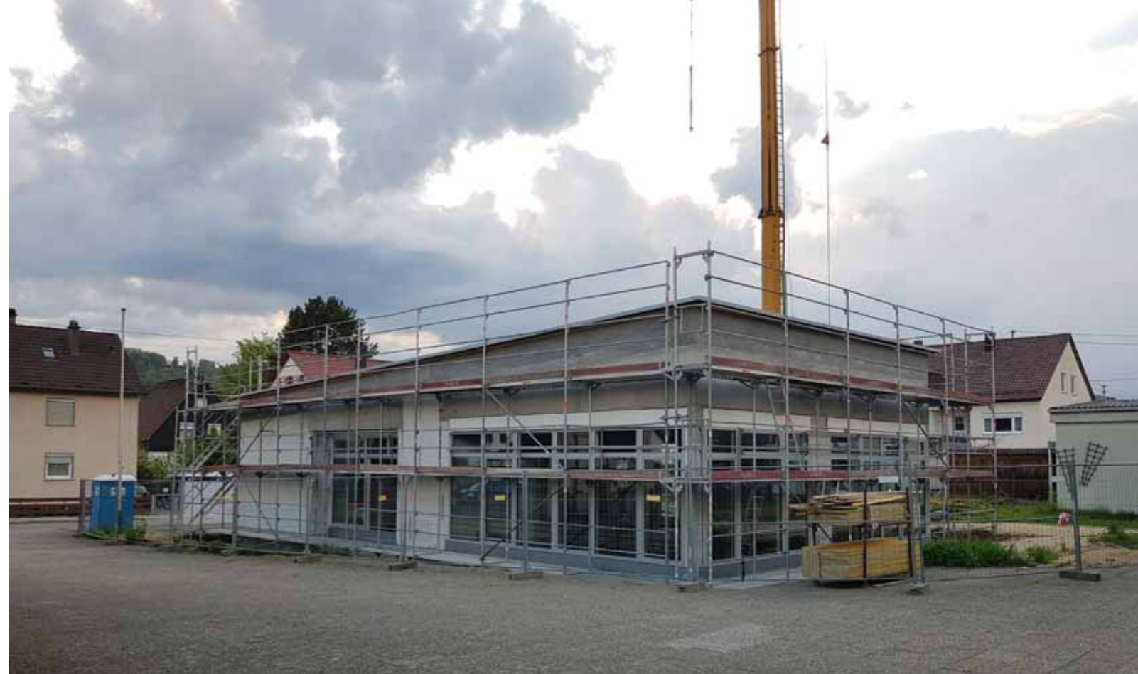
Der Rohbau des Gemeindezentrums in Gingen. Die Aufnahme ist aus dem Mai 2022
